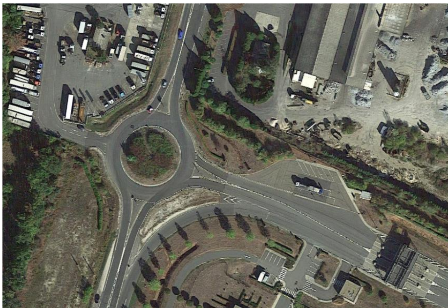
Vue aérienne de l'échangeur
