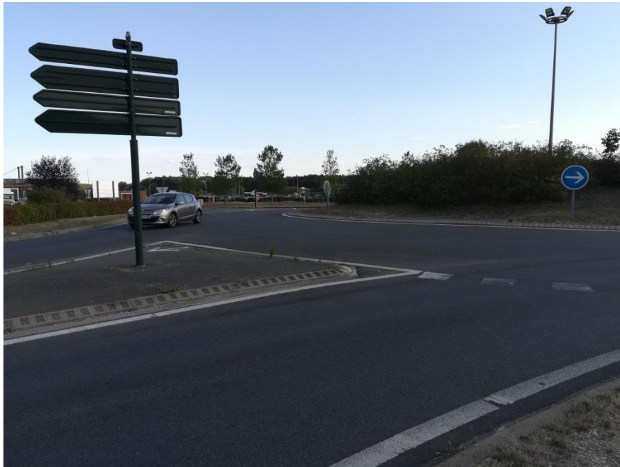
Vue du giratoire depuis la branche nord
