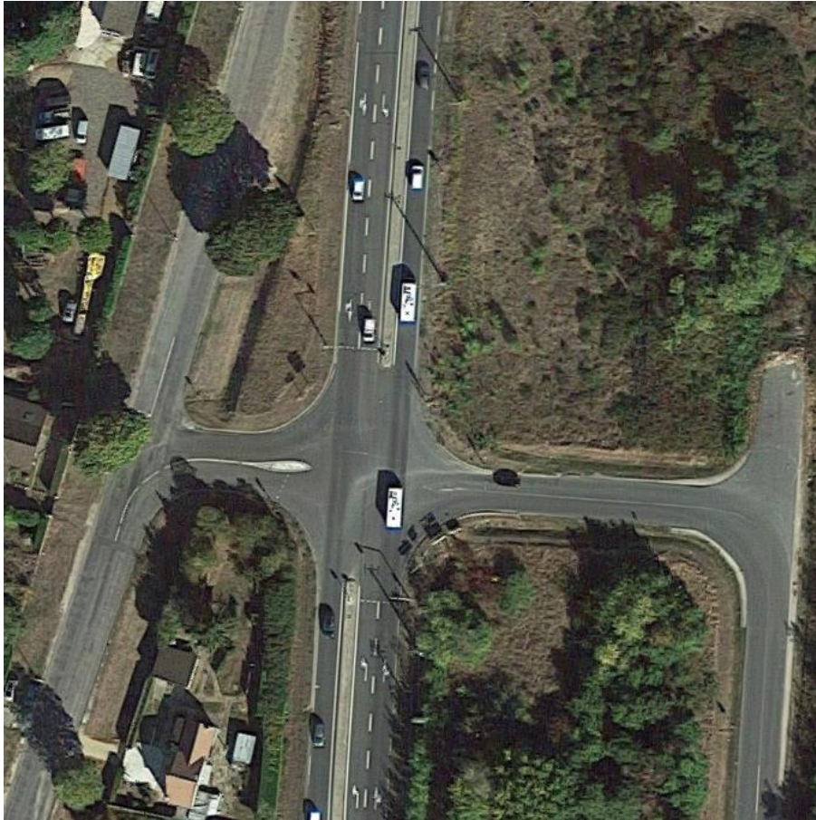
Vue aérienne du carrefour à feu
